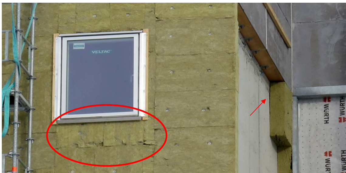
Fig. 10. Billeder fra opførelsen af nr. 13-15. Øverst oversigtsbillede der viser, hvordan REDAir batts er sat op med discs/skruer og LVL lister over samlingerne. Der er lodrette samlinger, der ikke er dækket (gule pile). Rød pil markerer et sted, hvor et af isoleringsbatts'ne er beskadiget og ikke slutter tæt i den vandrette samling. Nederst et nærbillede, der viser hvordan isoleringen er sat op i mindre stykker, hvoraf ikke alle er mekanisk fastgjort. Pilen th viser, hvordan der kan være lufttrum bag isoleringen, fordi betonen ikke er tilstrækkeligt plan. De to billeder er ikke taget samtidigt.
