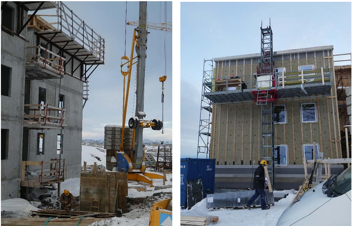
Fig.1. Fotos fra opførelsen af Unaaq-byggeriet viser ydervæggenes konstruktion. Tv den rå insitu-støbte beton, th er isolering og vinduer monteret, og den udvendige beklædning er ved at blive sat op.
