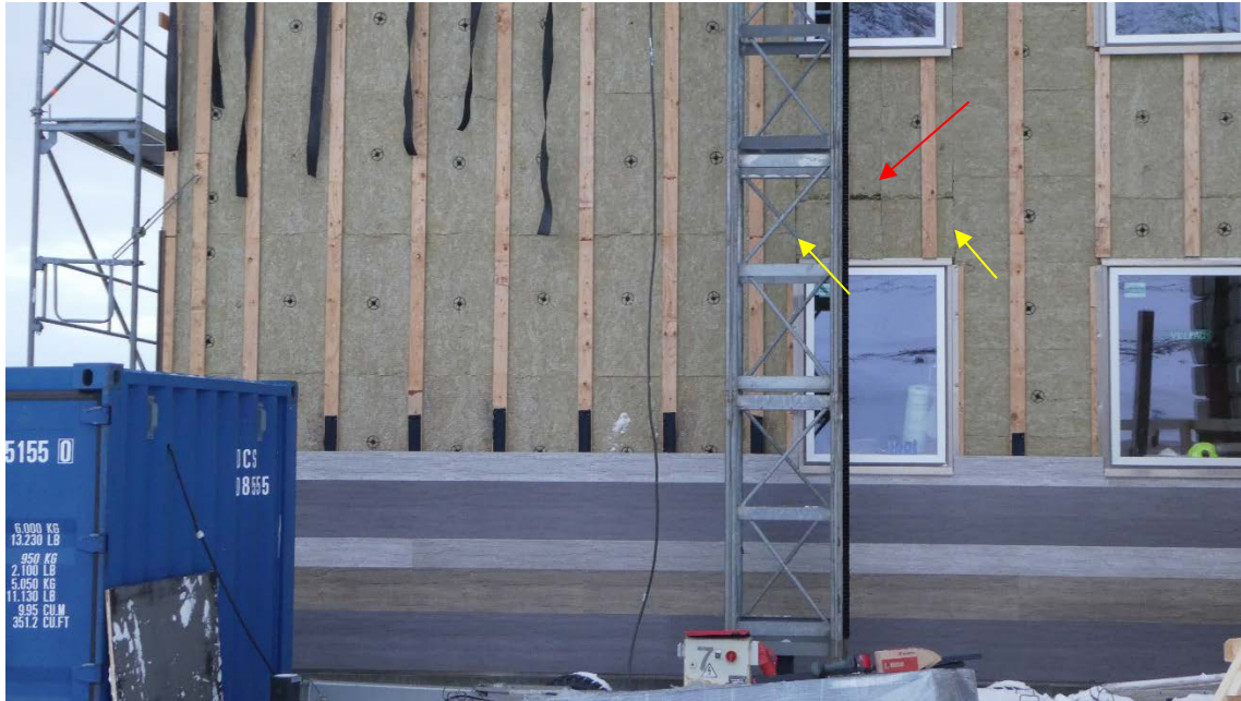
Fig. 10. Billeder fra opførelsen af nr. 13-15. Øverst oversigtsbillede der viser, hvordan REDAir batts er sat op med discs/skruer og LVL lister over samlingerne. Der er lodrette samlinger, der ikke er dækket (gule pile). Rød pil markerer et sted, hvor et af isoleringsbatts'ne er beskadiget og ikke slutter tæt i den vandrette samling. Nederst et nærbillede, der viser hvordan isoleringen er sat op i mindre stykker, hvoraf ikke alle er mekanisk fastgjort. Pilen th viser, hvordan der kan være lufttrum bag isoleringen, fordi betonen ikke er tilstrækkeligt plan. De to billeder er ikke taget samtidigt.
