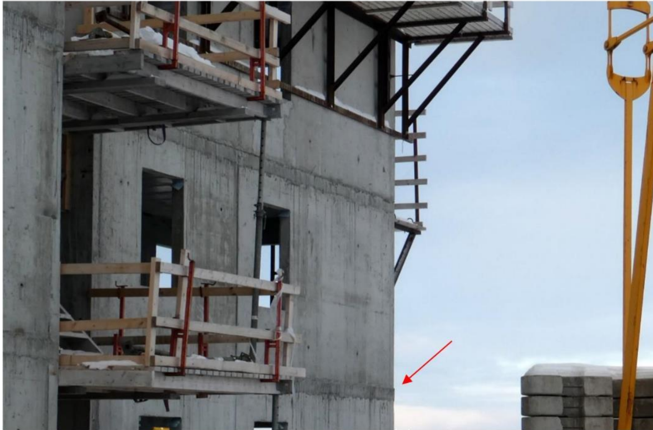
Figur 9. Fotos fra opførelsen. Især omkring etagedækkene ser betonoverfladen ud til at være mere ru end Rockwools (nuværende) forskrifter. På billedet øverst kan man på hjørnet af nederste etageadskillelse (rød pil) se, at ujævnheden må ligge over de maximale 5 mm. På foto herunder ses tilsvarende ujævnheder omkring etagedækket, men også brystningerne ser ud til at være ujævne.
