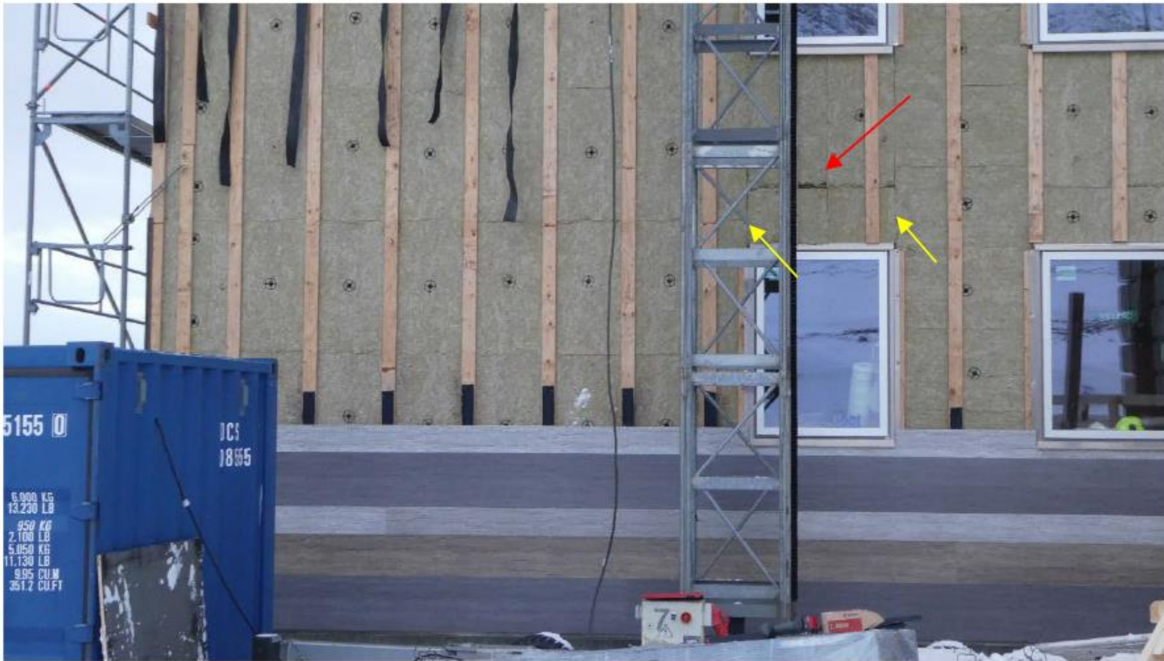
Fig. 10. Billeder fra opførelsen af nr. 13-15. Øverst oversigtsbillede der viser, hvordan REDAir batts er sat op med discs/skruer og LVL lister over samlingerne. Der er lodrette samlinger, der ikke er dækket (gule pile). Rød pil markerer et sted, hvor et af isoleringsbatts'ne er beskadiget og ikke slutter tæt i den vandrette samling. Nederst et nærbillede, der viser hvordan isoleringen er sat op i mindre stykker, hvoraf ikke alle er mekanisk fastgjort. Pilen th viser, hvordan der kan være luftrum bag isoleringen, fordi betonen ikke er tilstrækkeligt plan. De to billeder er ikke taget samtidigt.
